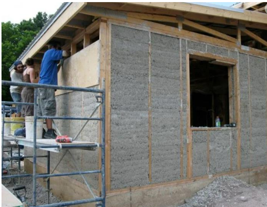
Figure 3 : construction à l'aide de béton de chanvre
