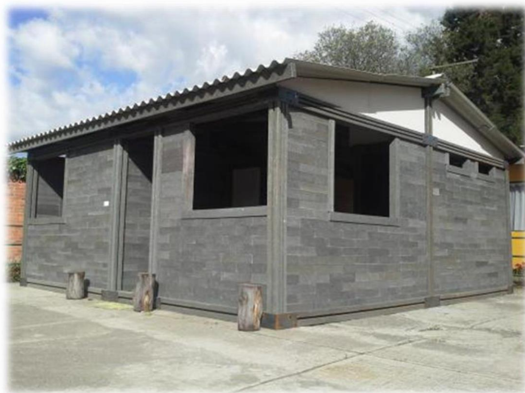
Figure 7 : maison construite par JD Composites à l'aide bouteilles en plastique
