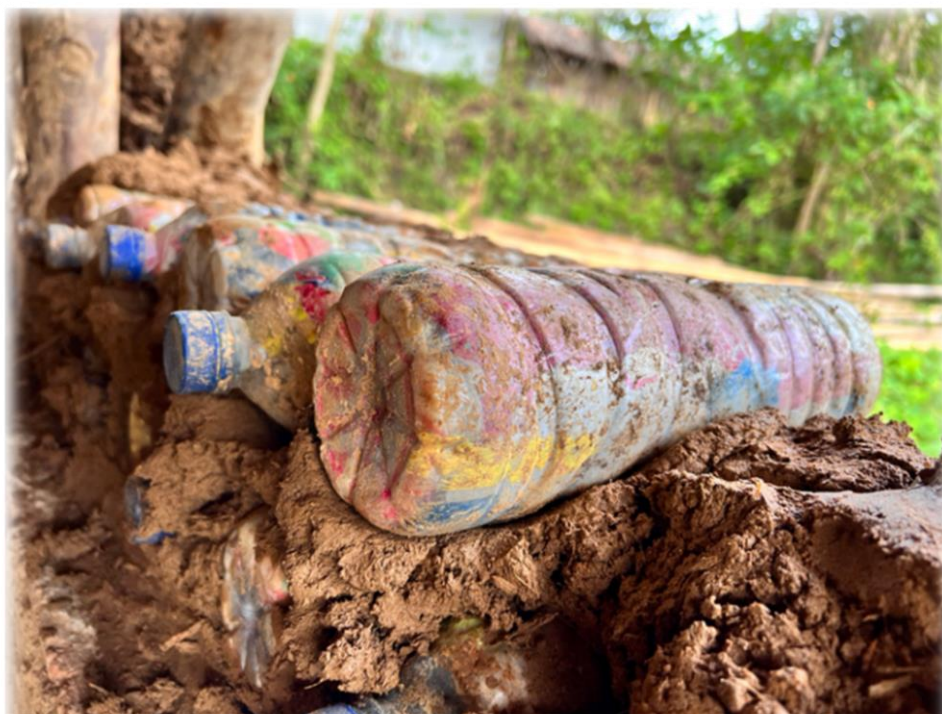
Figure 5 : construction à l'aide de bouteilles remplies de déchets plastiques
